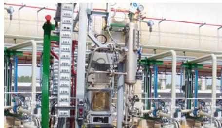
Насос дезанизатора на установке фракционирования сжиженного нефтяного газа на НПЗ ENOC, **ОАЭ**, оборудован двойной безнапорной уплотнительной системой EagleBurgmann по API 682.
