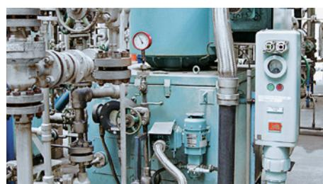
Fujian Refining & Petrochemical Co., Ltd. в **Китае** использует насос BB2 для десфальтизации пропаном. Для вала применяется уплотнение EagleBurgmann типа А по API. Конфигурация 2CW-CW, схемы подачи 21+52. Условия эксплуатации:  $p = 73$  бар изб. (1 059 PSI изб),  $t = 165^{\circ}\text{C}$  (329 °F),  $n = 2\ 970$  мин $^{-1}$ .
