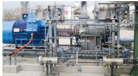
Питательный насос Sulzer HDS типа GSG 100-300 используется на НПЗ Total в г. Лойна, **Германия**. Герметичность обеспечивает разгруженное пружинное уплотнение EagleBurgmann по API с защитным уплотнением (конфигурация 2CW-CS). Подача по схеме 75 (системы EagleBurgmann для подачи газа и сбора утечки). Условия эксплуатации:  $p = 6 \text{ бар изб.}$  (87 PSI изб.),  $t = \text{макс. } 120^{\circ}\text{C}$  (248 °F),  $n = 2\ 980 \text{ мин}^{-1}$ . Среда: Углеводород (керосин).
